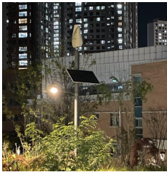
태양광 에너지 이용 가로등
