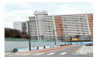
개선(통학로 가림막 설치)
