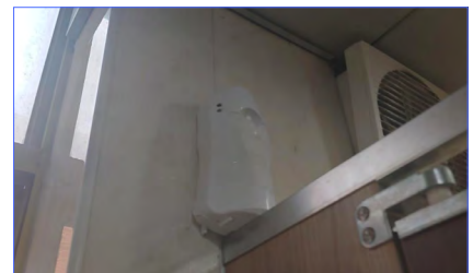
화장실 방향제 설치
